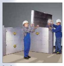
Если Вы укрепляете замкнутую шахту, то соберите все стороны из стенок, а потом зафиксируйте конструкцию пальцами.
