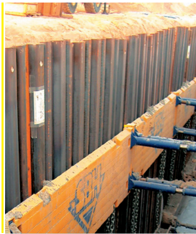
Стенки профильной крепи h = 1,00\text{м}
